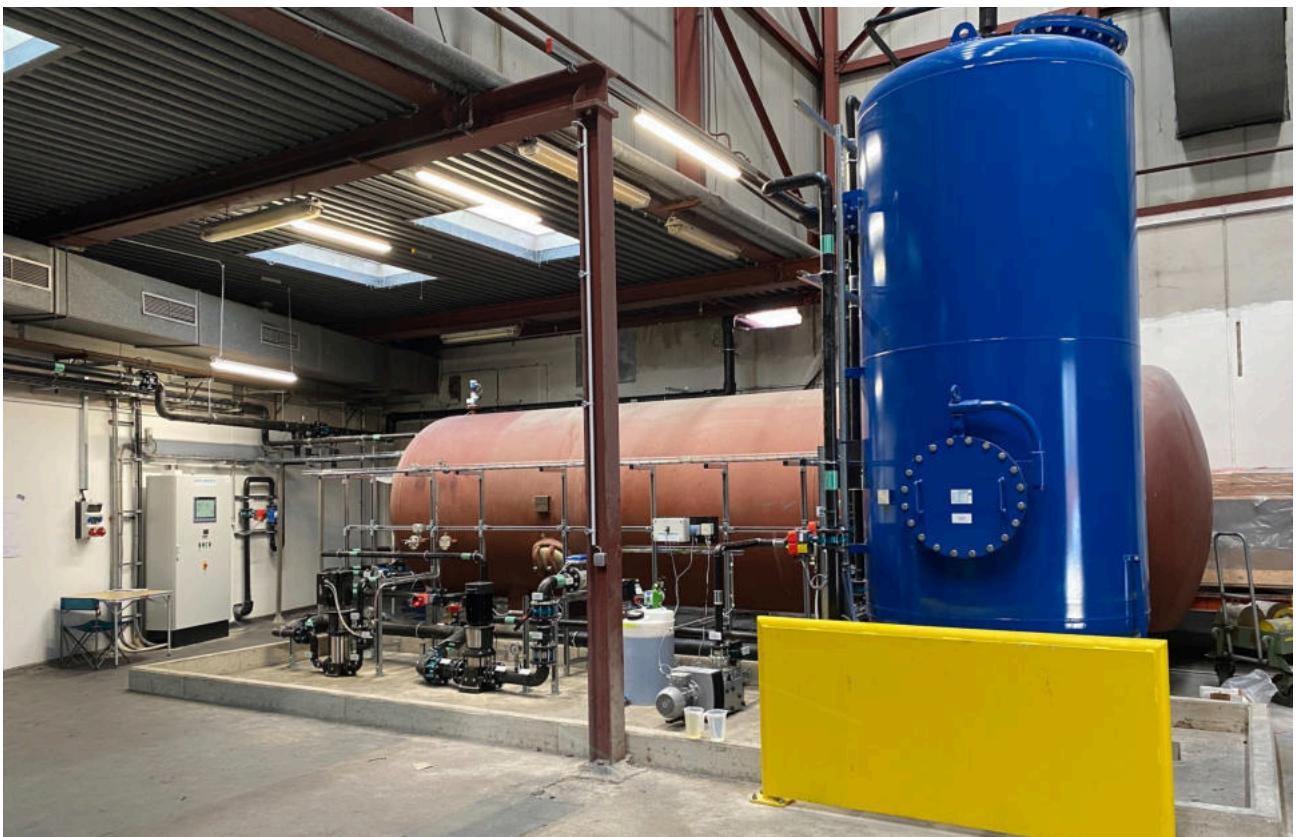
Die Aufbereitungsanlage hat eine Kapazität von 15 m<sup>3</sup>/h und wurde schlüsselfertig von BWS errichtet. Dies ist ein gelungenes Beispiel dafür, wie durch die umfassende Analyse der Wasserkreisläufe im Werk Wasserverbraucher und brachliegende Potenziale genutzt werden können, mit dem Erfolg, dass gesamtheitlich betrachtet erheblich Wasser und damit Kosten eingespart werden können.
